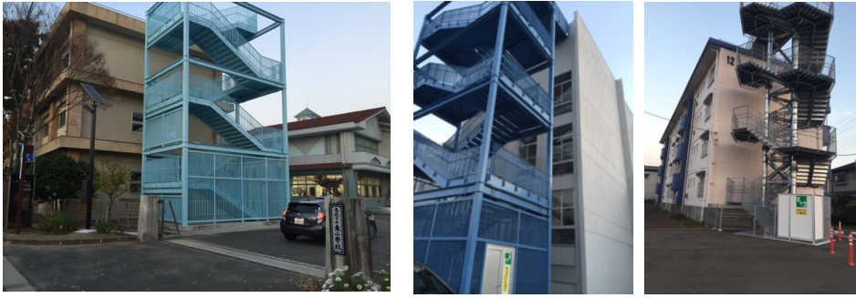
左から高萩市立東小学校、高萩中学校、高萩市営住宅に整備した避難階段
