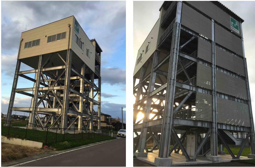
青森県八戸市多賀地区の津波避難タワー
