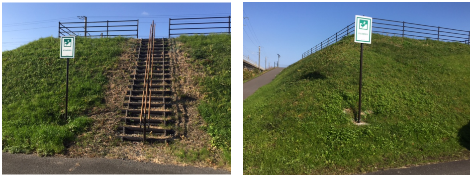
日立市南部の留町に整備された津波からの避難マウンド（築山）
